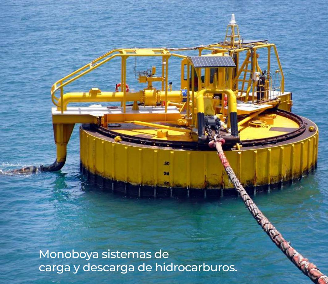
Monoboya sistemas de carga y descarga de hidrocarburos.
